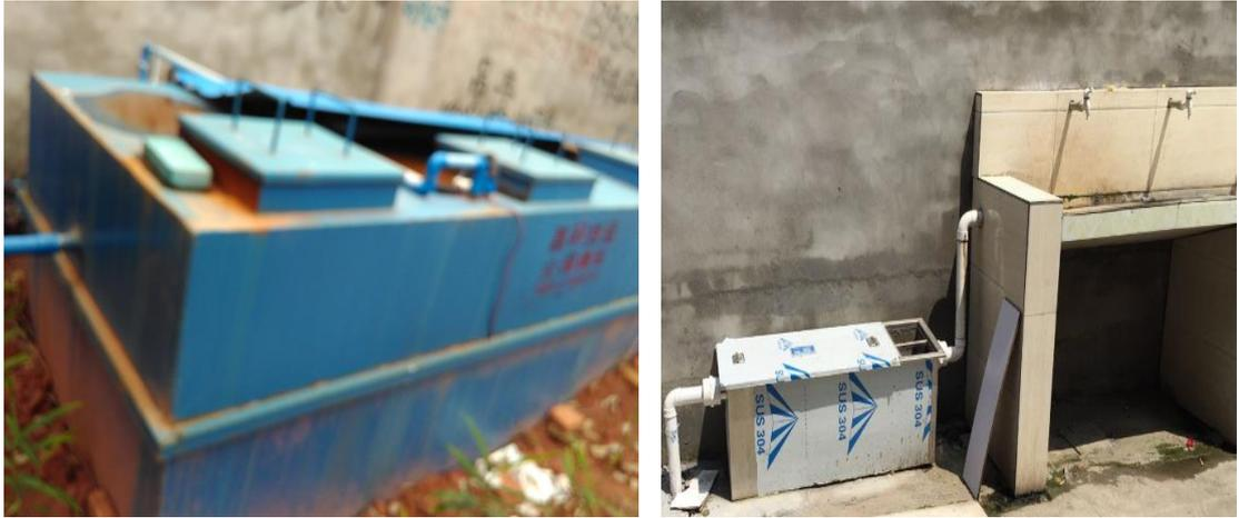
图 3-2 园区一体化污水处理设施及隔油池
